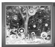
Nachträglich: dicht angebrachte Aufkleber verhindern Kollisionen.
