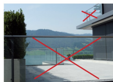
Frei stehende Glaswände (Windschutz) oder Eckverglasungen (Loggia, Wintergarten, Eckfenster) täuschen den Vögeln einen freien Durchflug vor.
