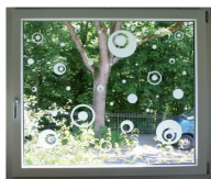
Nachträglich: dicht angebrachte Aufkleber verhindern Kollisionen.
