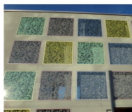
Bei rechtzeitiger Planung vor dem Bau: gemustertes Glas macht das Hindernis für die Vögel sichtbar.
